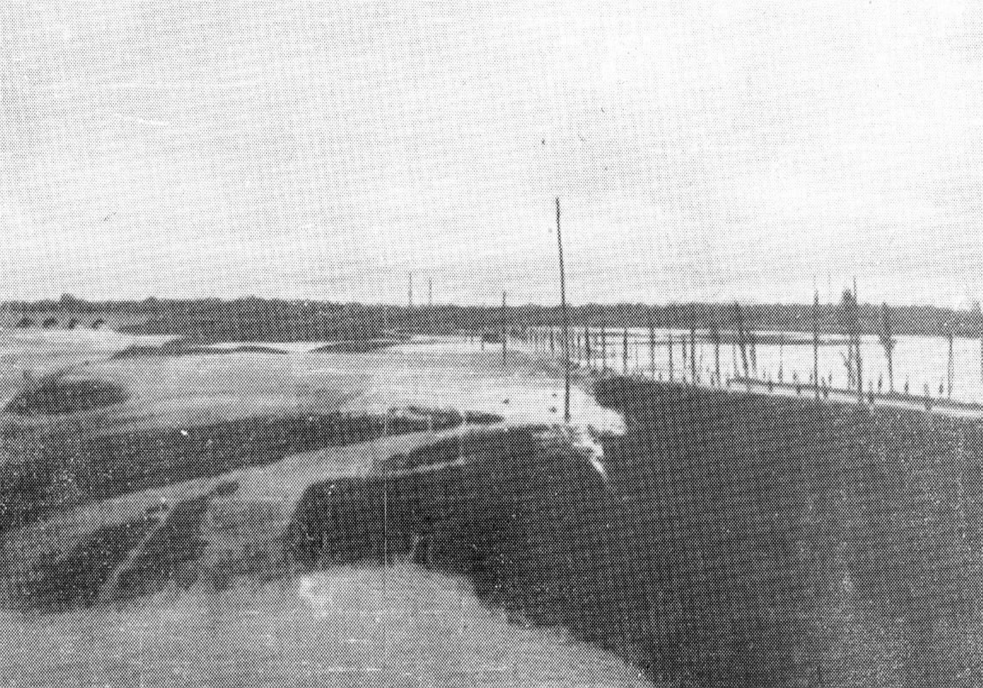
Torrente CERVARO a Ponte Incoronata 1940
